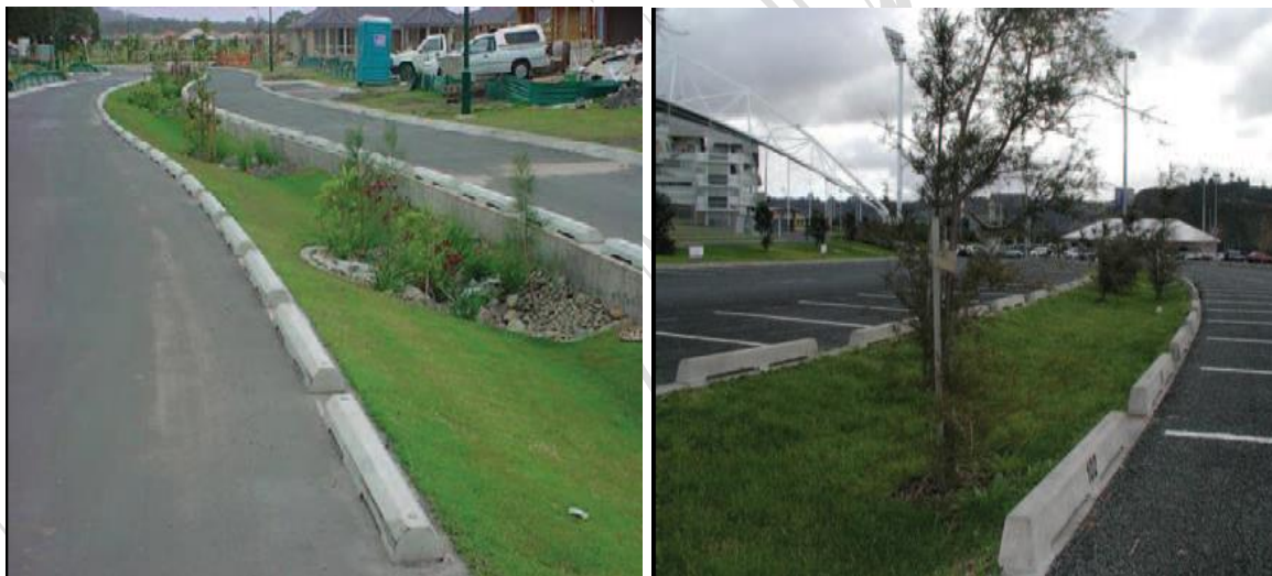
شکل ۵- ایجاد شیار در بین جداول خیابان به منظور هدایت آب به باغچه کنار خیابان (Allison, 2005)
